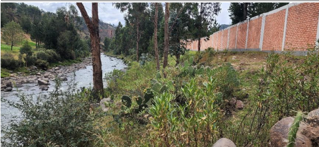
FIGURA N°03: VISTA DE MURO PERIMETRICO ALEDAÑOS A LA RIBERA DEL RÍO HUARPA (RÍO VINCHOS), LOS MISMOS QUE ESTAN SIENDO EROSIONADOS Y SOCAVADOS EN ÉPOCA AVENIDAS.
